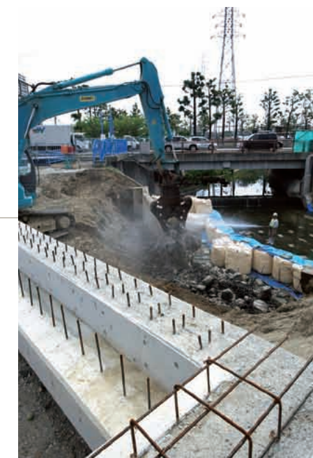
白ヶ池川と県道、バイパスが交差する山ノ越交差点では護岸改修が進行中。河川工事も擁する多工種の現場だ。
