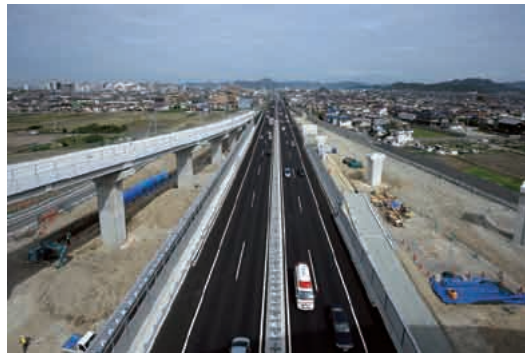
ここから北側(右方向)へ延びる東播磨南北道路は、近年開院した兵庫県立加古川医療センターへの緊急搬送ルートとしての機能も担う。
