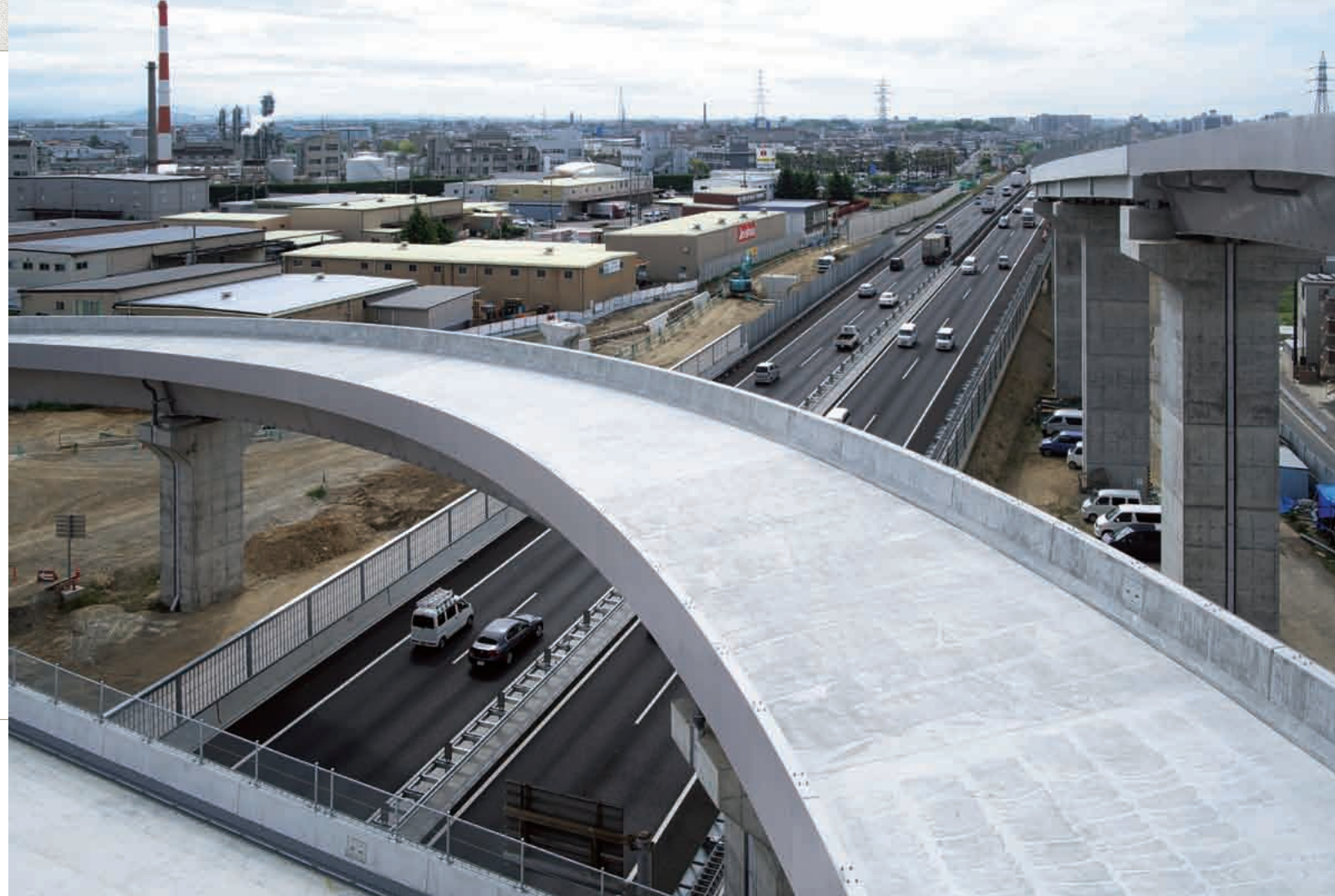
新しく建設されたJCT橋梁部から国道2号加古川バイパス神戸方面を望む。バイパスは1日10万台もの車が行き交う、日本で8番目に交通量の多い自動車専用道路だ。
