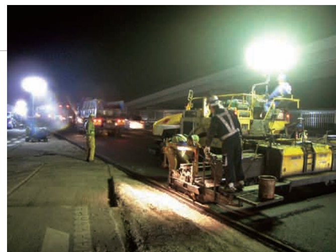
迂回路からバイパス本線への切替工事は上下線各32時間の超急速施工を達成。昨年の9月と10月の2回に分けて行われた（提供：奥村組）。
