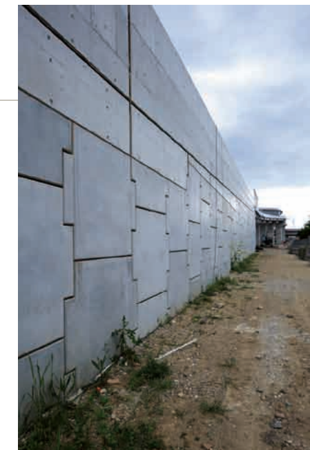
本線拡幅部に擁壁を施し、側道を設ける。他の施工地点でもそれぞれの地理的条件を考慮し、様々な工法が採用される。
