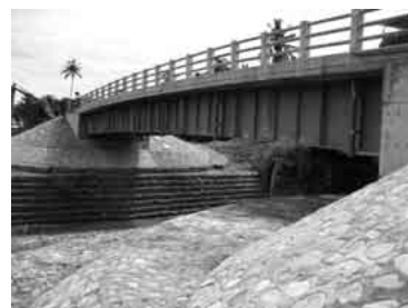
ギドシット橋 (終点側より全景)
