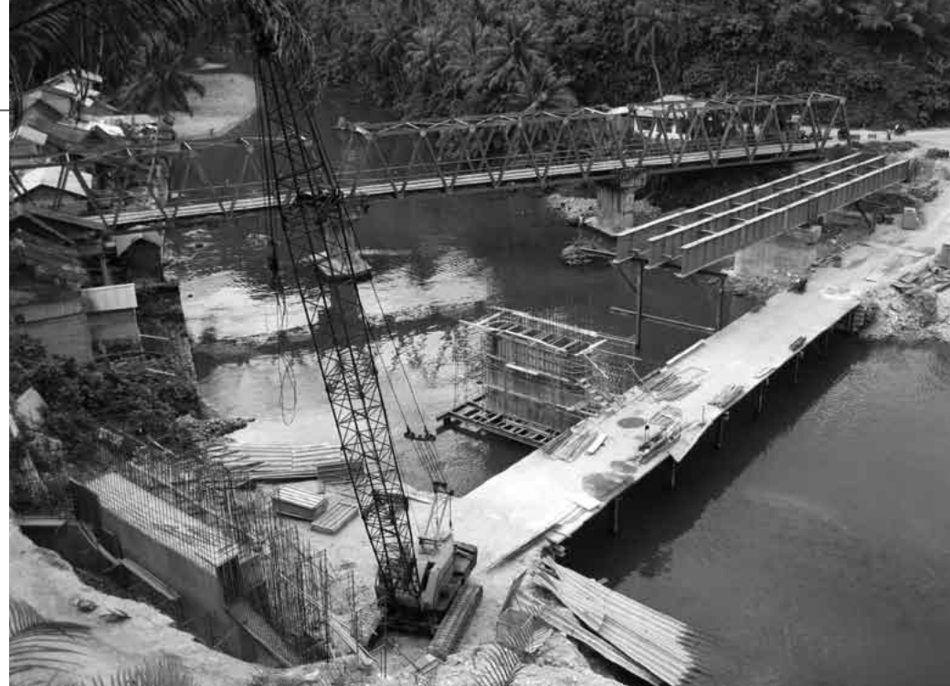
メザヤ橋 (終点側より全景)
