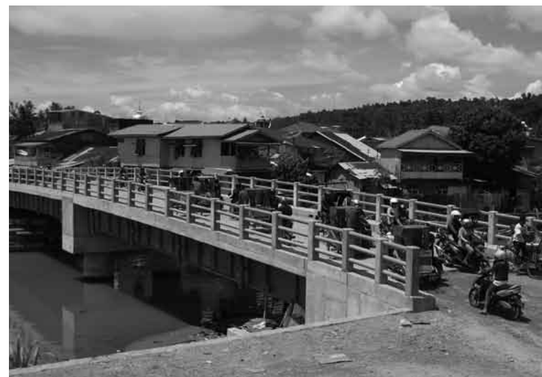
ノウA橋 (完了全景)
