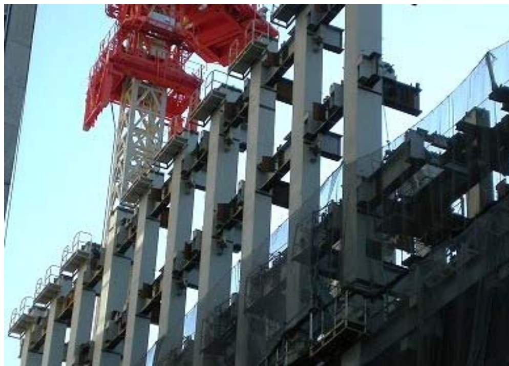
外周部鉄骨の防せい塗装例
