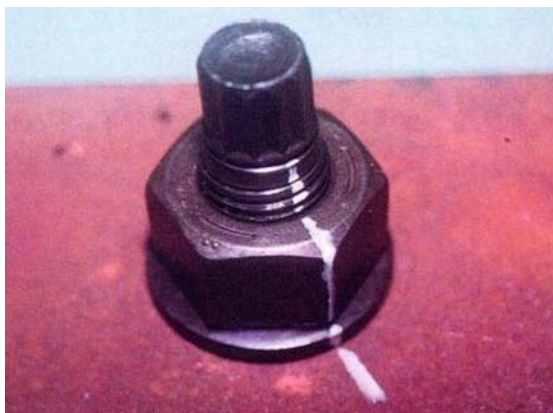
1次締め付け後 (ナットの角にマーキングする)
