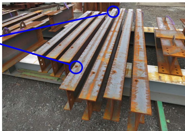
仮置きされた小梁
