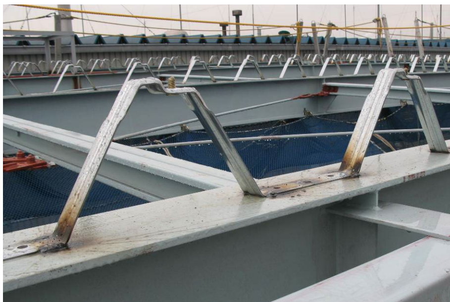
さび止めペイントの上から溶接を行った例
