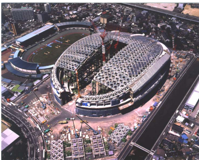
大空間建物の建方状況
