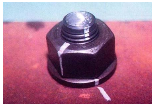
本締め完了時
