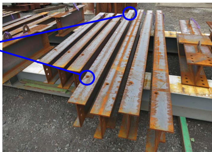
仮置きされた小梁
