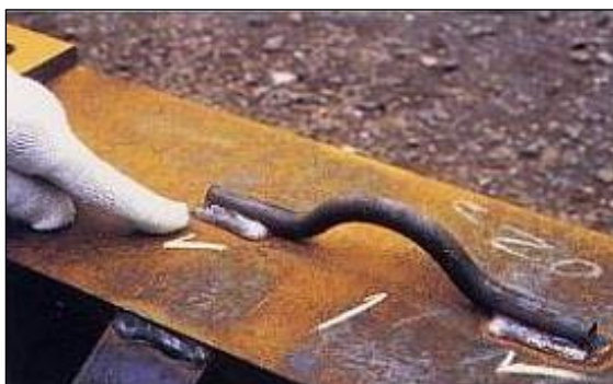
写真3.自主検査状況
