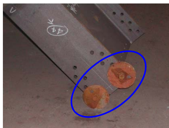
鋼板の残材(貫通孔を抜いた残材など)を利用した保護治具
