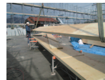
現場で地組み後、ボルトでつづる
