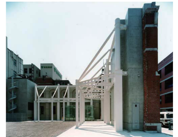
地下鉄へのアプローチ
