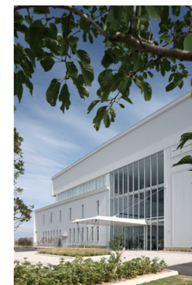
北側外観 前面の駐車場を緑化
