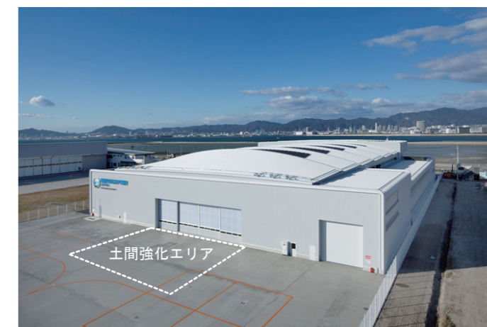
南西側俯瞰 六甲山系を望む
