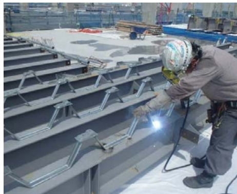
溶接作業状況
