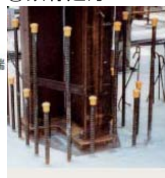
⑤鉄骨建方
