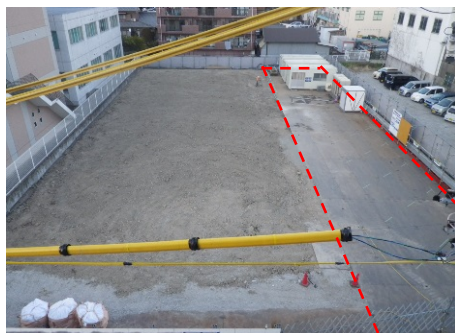
鉄板敷き状況
