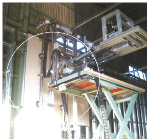
リフターを伸ばし高さ4mの壁面へのボード張り
