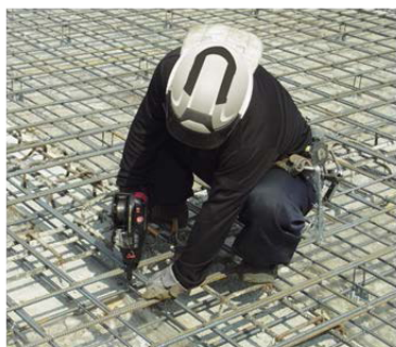
スラブ面での結束作業の様子
