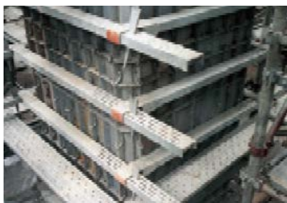
鋼製型枠使用例
