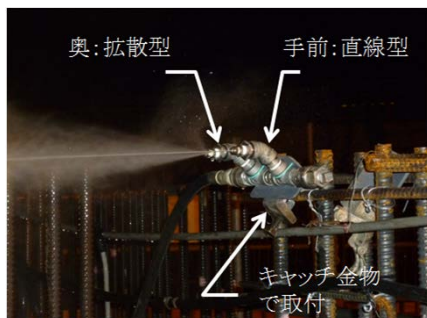
散水ノズルによるミスト状散水の状況
