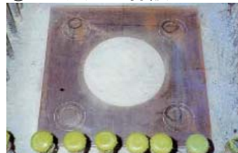
④サップボルト溶接完了
