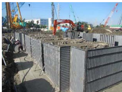
RADIX型枠建込状況
