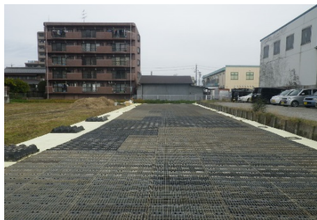
敷き込み完了
