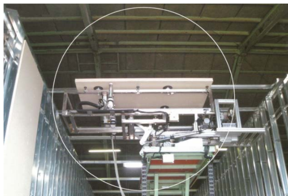
バンド部を上向け天井面へのボード張り
