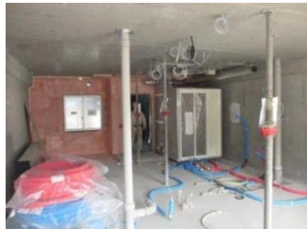
N-2階 室内状況
