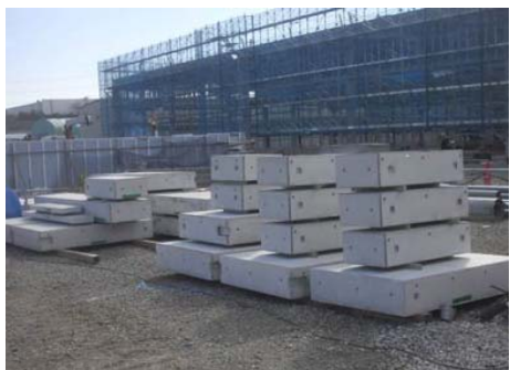
外構設備基礎のサイトPCa化事例
