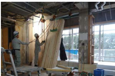
適用事例③ CLTを用いた耐震改修事例
