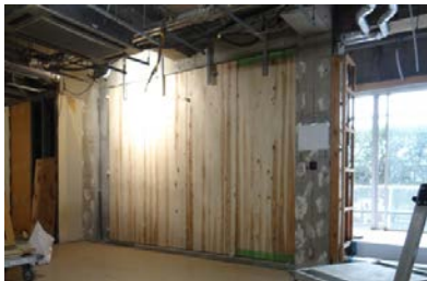
適用事例③ CLTを用いた耐震改修事例
