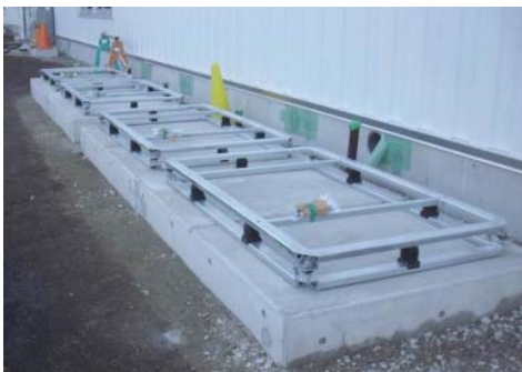
外構設備基礎のサイトPCa化事例
