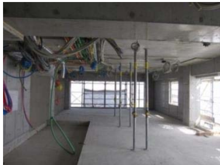
N-1階 室内状況
