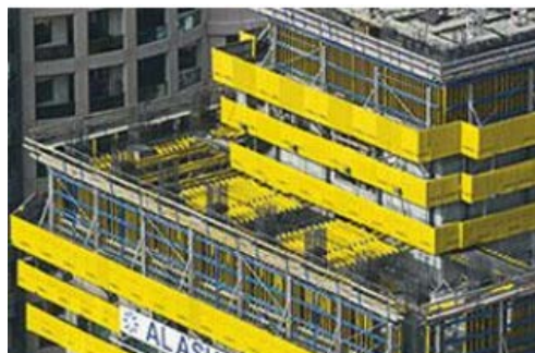
クレーンを使用せず、あらゆる形状、高さの躯体に適したクライミング型枠 セルフクライミング型枠 SKEplus
