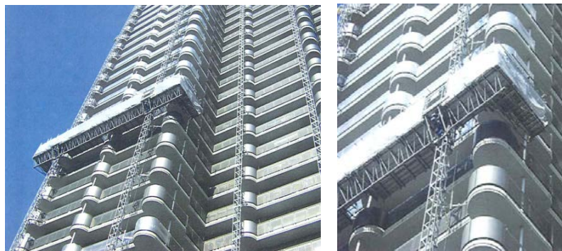
外壁改修工事での使用例
