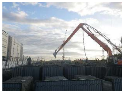
先行埋め戻し完了状況
