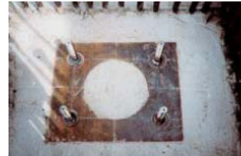
④サップボルト溶接完了
