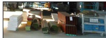
荷降ろし階での 資材整理状況
