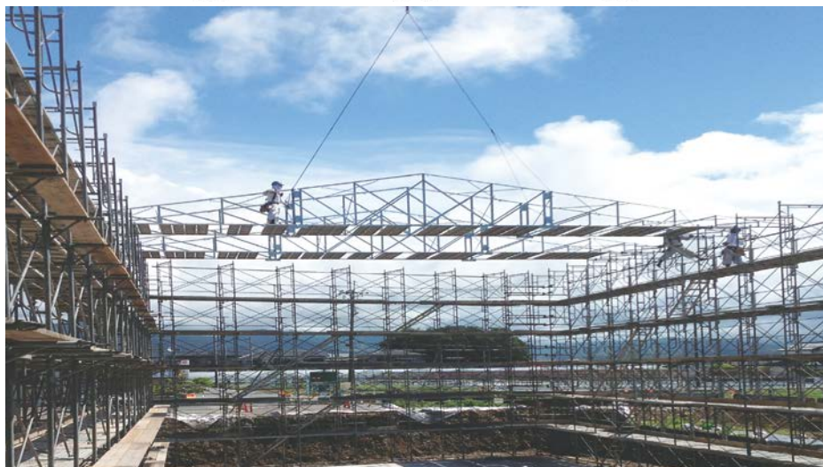
簡易屋根トラスの取り付け状況
