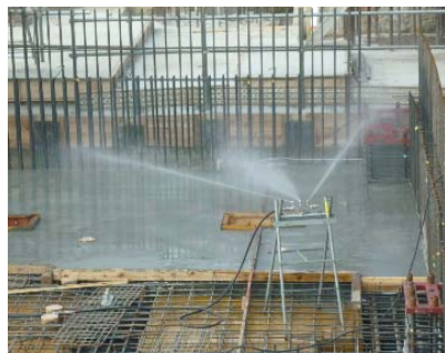
散水ノズルによるミスト状散水の状況
