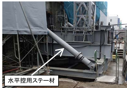
鉄骨架台設置状況②
