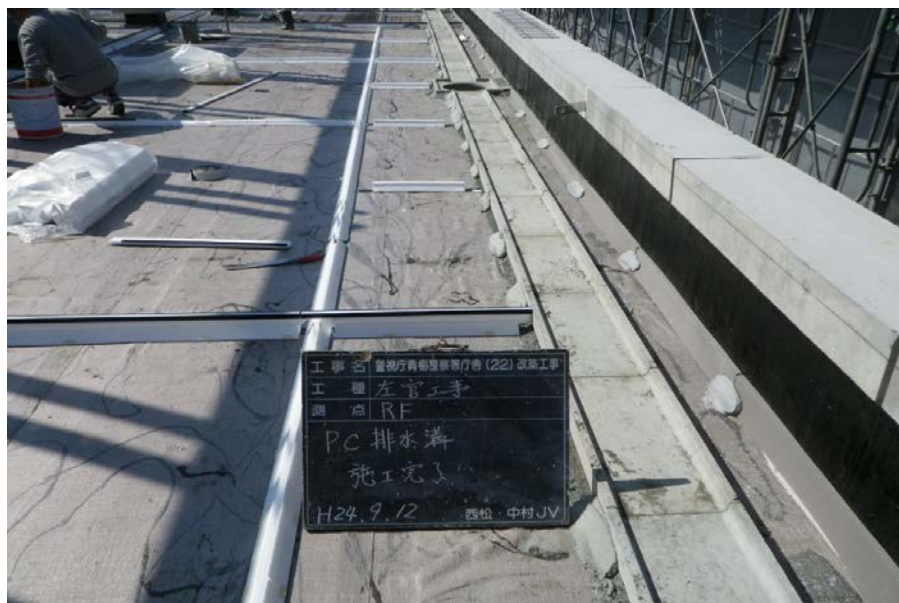
↑ 設置完了状況
