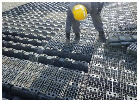
敷き込み状況
