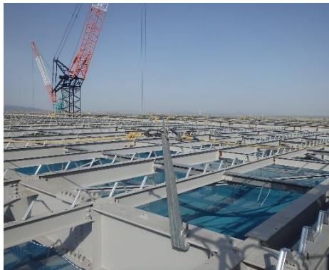
建方完了状況
