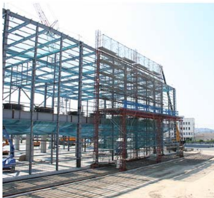
作業用移動足場
