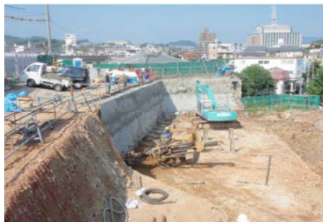
削孔・締め付け
