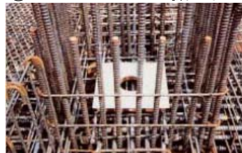
②アンカープレート据え付け
