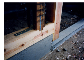
土間レベルの嵩上げ
