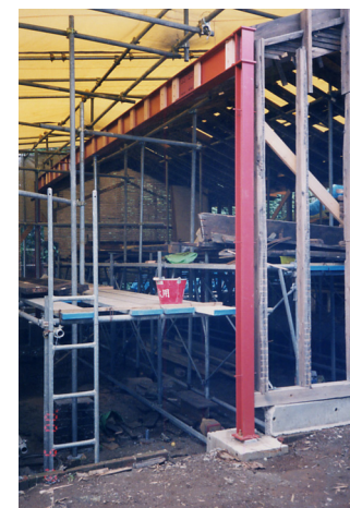
教室棟の鉄骨補強
