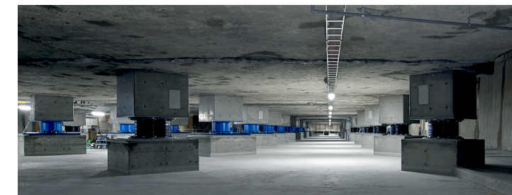
完成後の免震層内部状況
