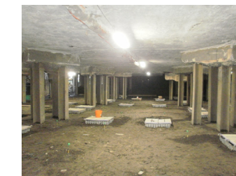
掘削中の状況
