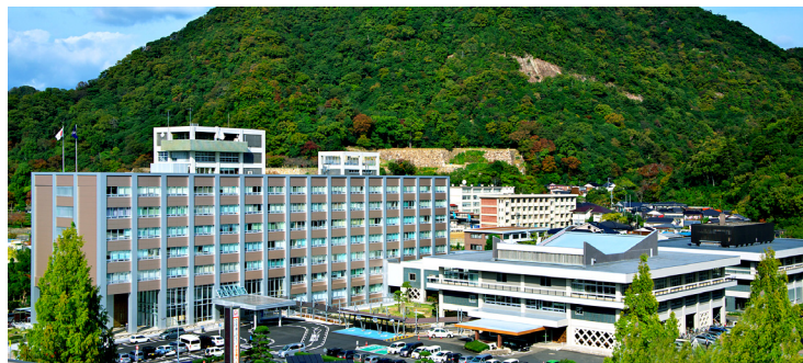
鳥取県庁舎全景（耐震改修後）
