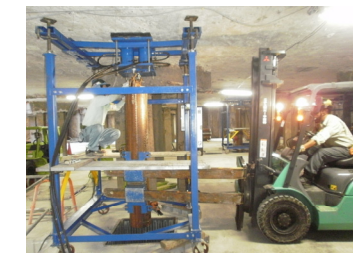
鋼管杭打設状況
