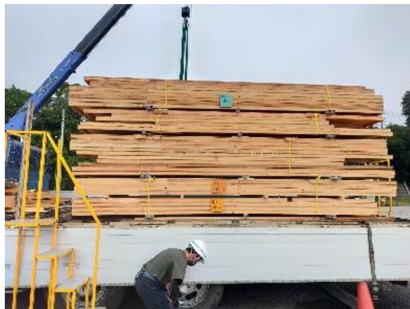
<型枠材現場搬入>
