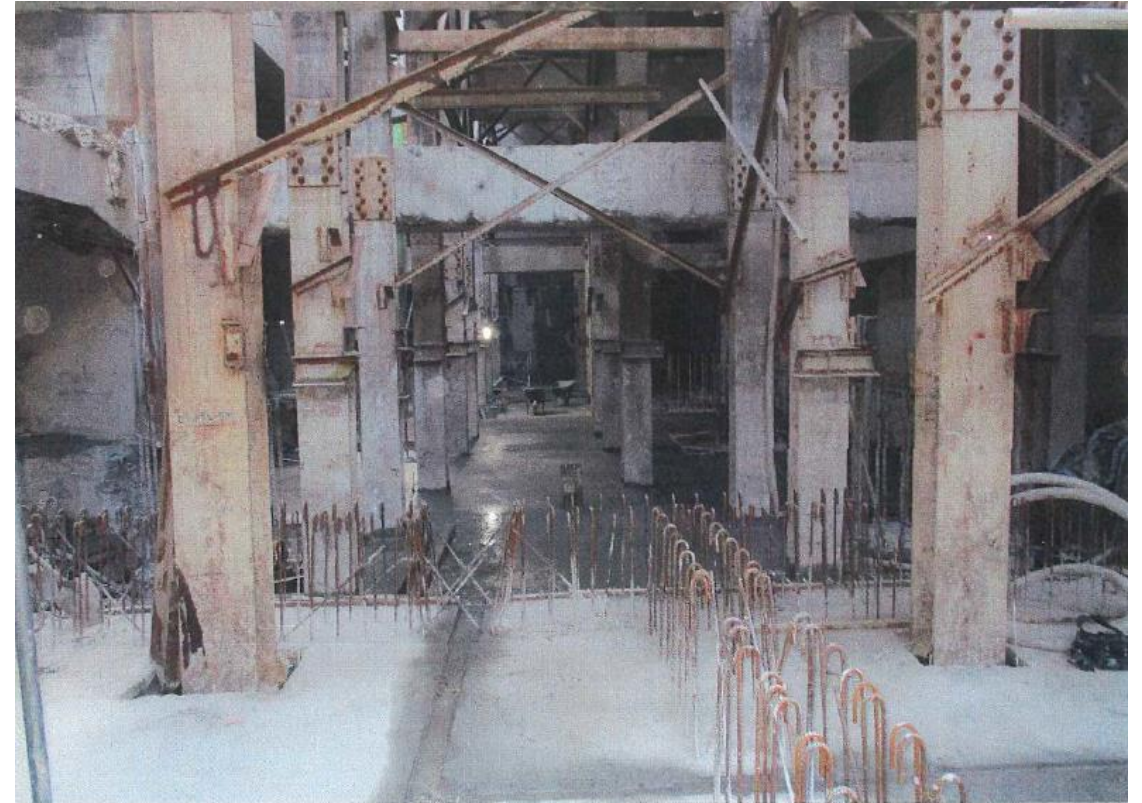
実際の施工状況
