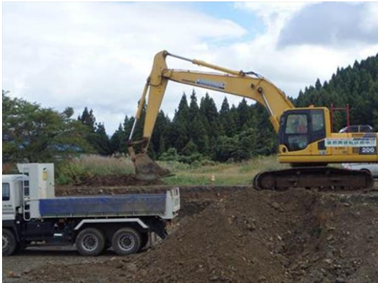
省燃費運転による積込掘削作業 実技指導中
