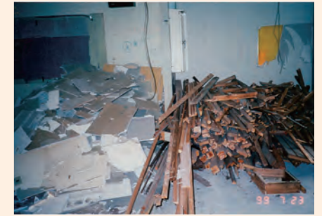
建設発生木材と廃石膏ボードの分別解体状況
