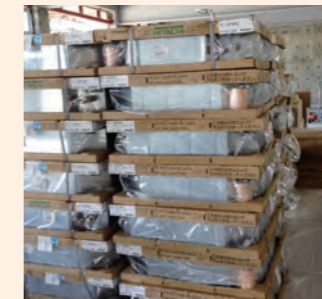
空調ダクトの無梱包搬入
