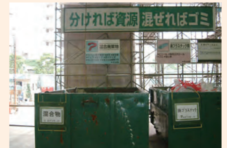
工事現場の分別ヤード
