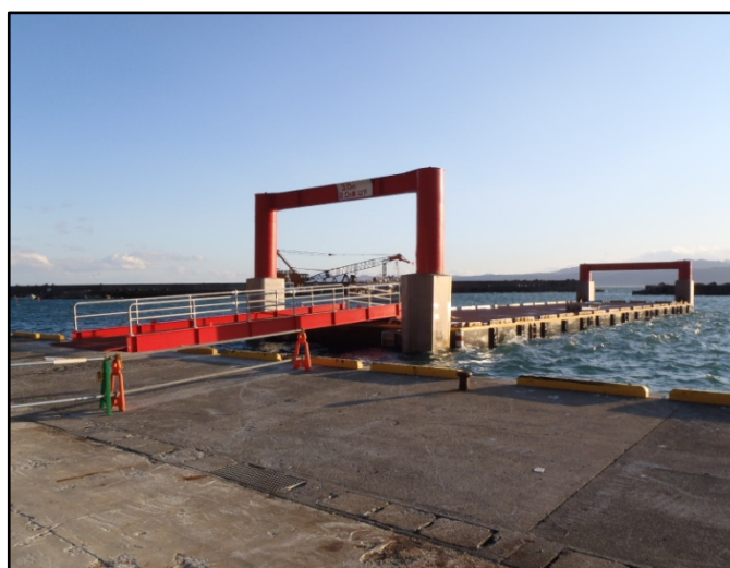
浮き棧橋復旧完了
