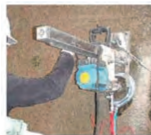
写真-2 コア削孔 ( \phi 42\text{ mm} )
