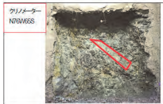
写真-1 計測対象の不連続面
