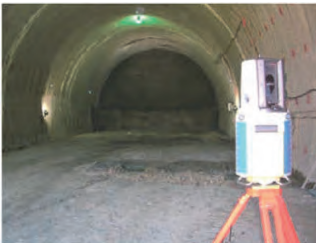
写真-1 3D スキャナによる計測状況
