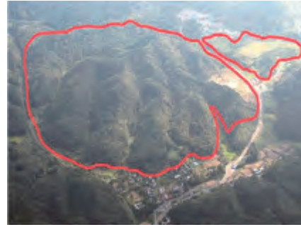
写真-2 工場掘削前全景
