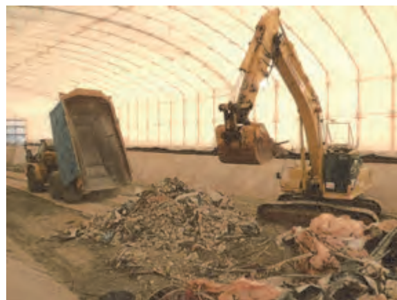
写真-4 高線量ガレキ収容状況
