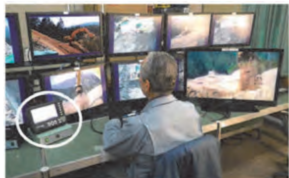
写真-3 ネットワーク伝送装置
