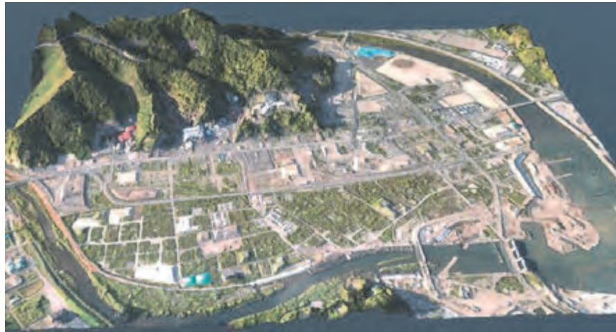
図-3 UAV 出来高測定の3D出力例
