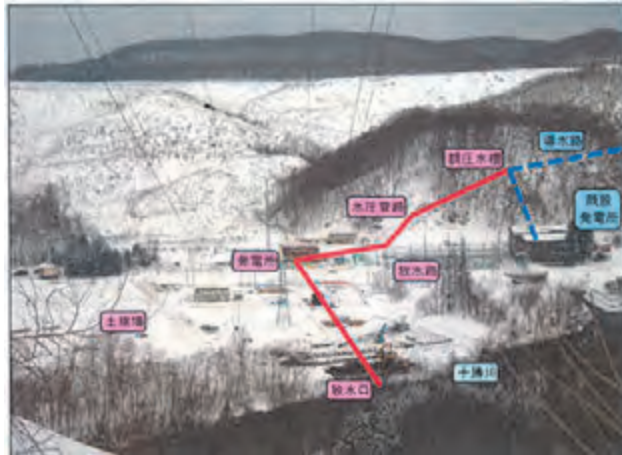
図-1 新岩松発電所施工箇所全景
