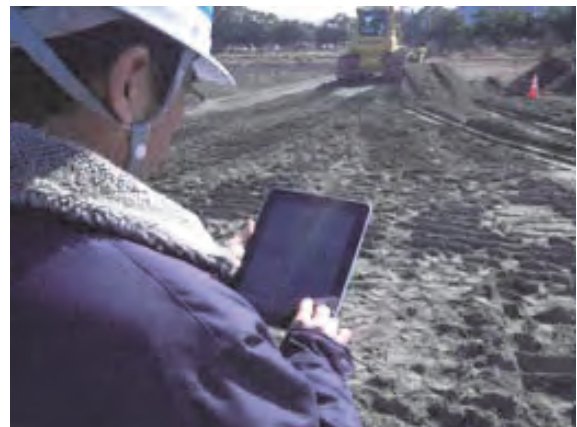
図-5 iPadによる施工管理
