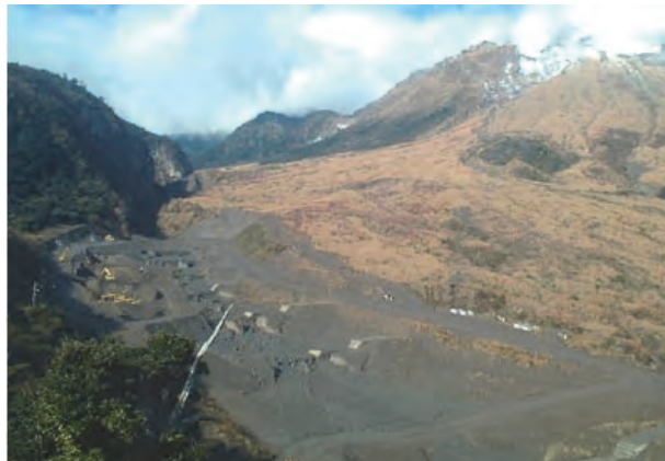
写真-3 現場全景
