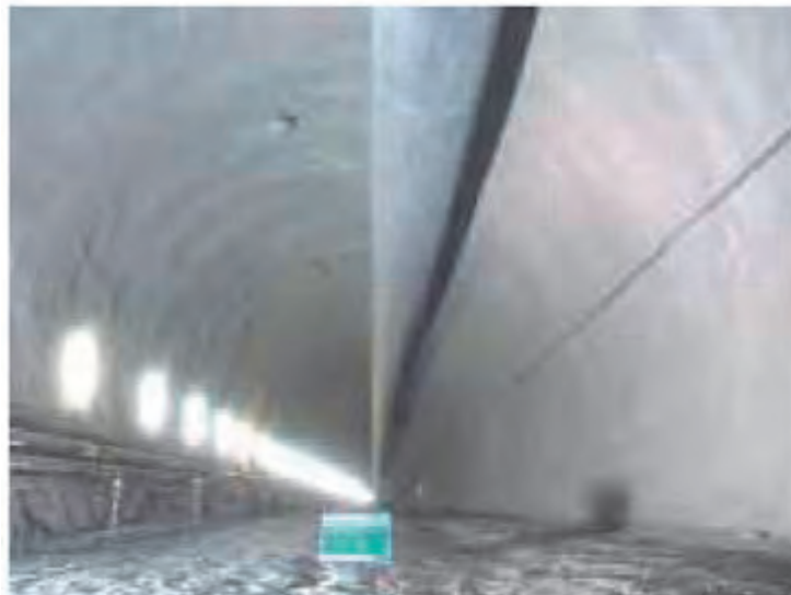
写真-3 掘削吹付け仕上がり状況
