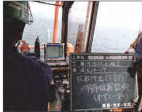
写真-2 吊荷位置監視状況
