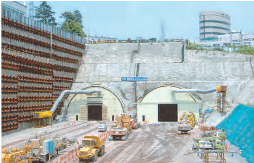
写真-1 施工中の今里第一トンネル坑口付近
