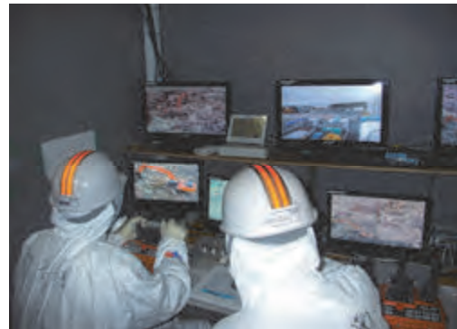
写真-2 無人化施工機械の操作状況
