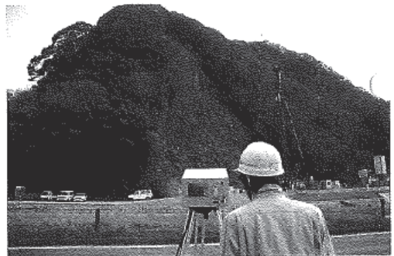
写真-1 3D レーザ計測状況
