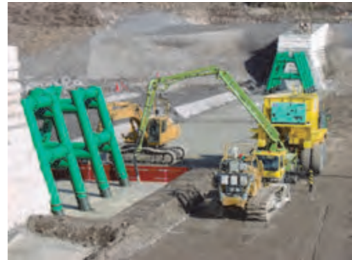
写真-5 無人ポンプ車による打設状況
