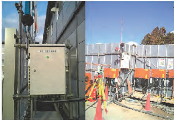
写真-5 騒音・振動計、粉塵計測盤
