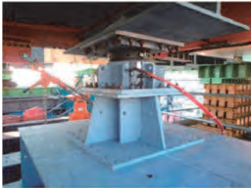
写真-4 550t 回転中心ジャッキ
