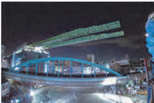
写真-2 第1回桁送出し全景
