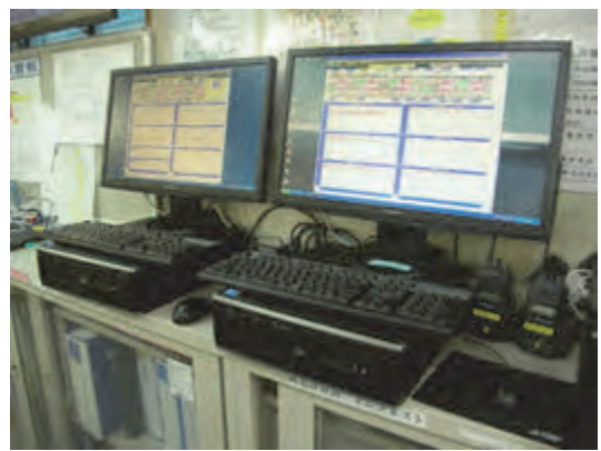
写真-2 モニター設置写真 (現場事務所内)
