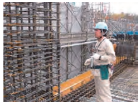
写真-1 鉄筋全数検査の様子
