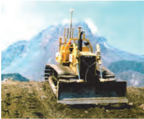
図-9 法面掘削状況
