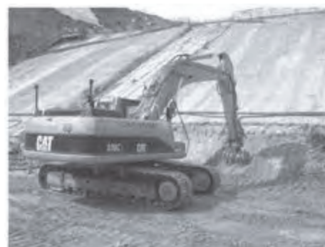
図-6 仕上げ掘削施工状況
