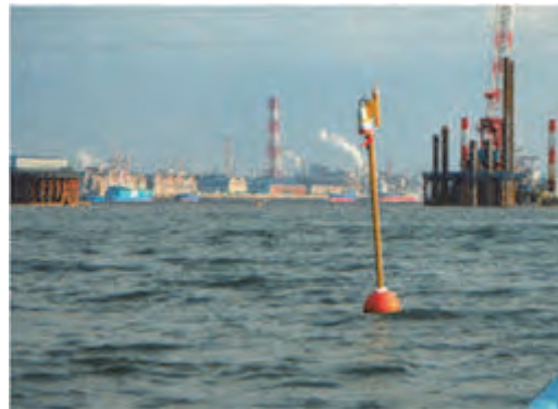
写真-2 通信制御装置の設置状況
