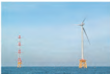
写真-1 風力発電施設の設置状況
