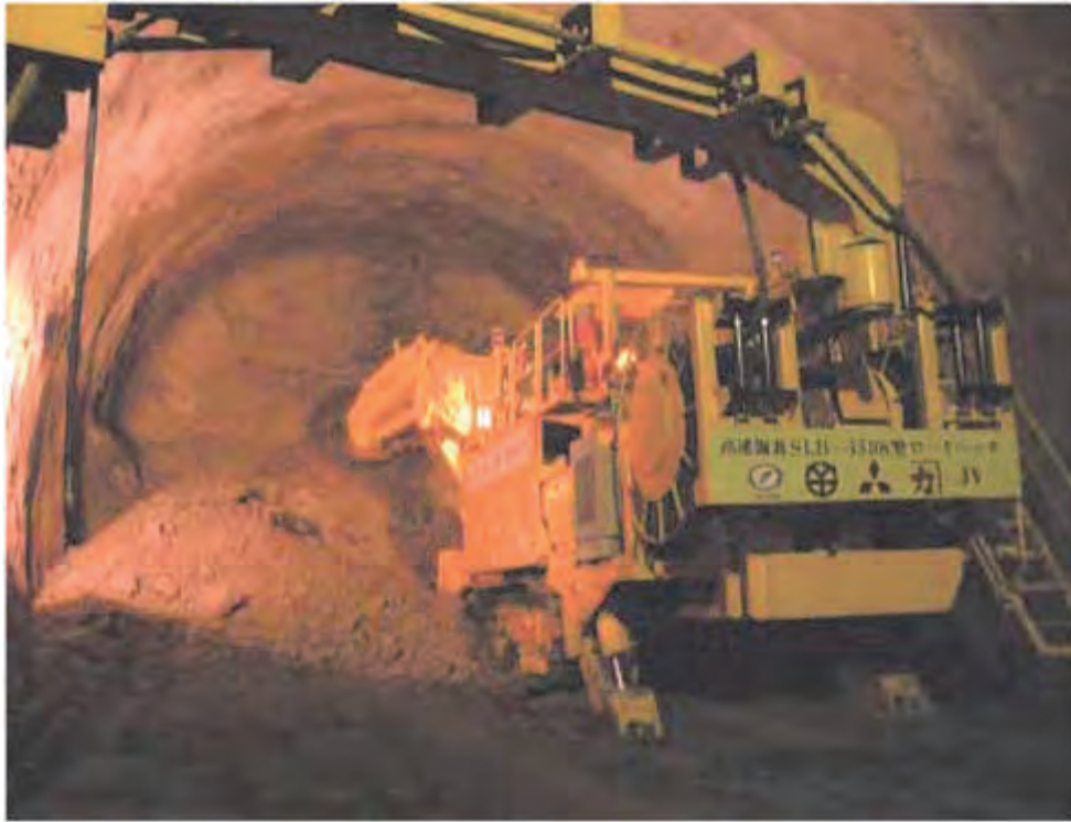
写真-1 高速掘進工法での掘削状況
