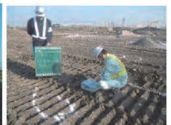
写真-2 RI法による計測
