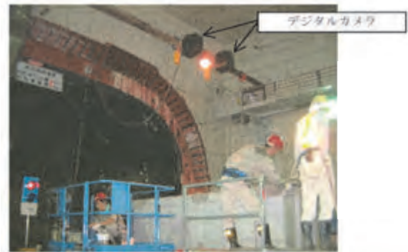
図-6 ズリ鋼車計測状況
