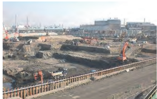
写真-1 掘削状況
