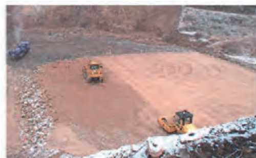
図-2 GNSS 締固めシステム
