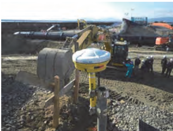
図-1 GNSS 基地局
