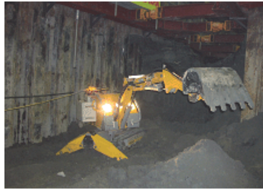
写真-3 掘削状況
