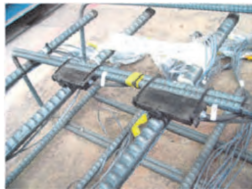
写真-2 コンクリート配筋に設置した RFID タグ
