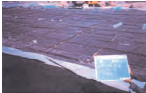
写真-2 電極敷設状況
