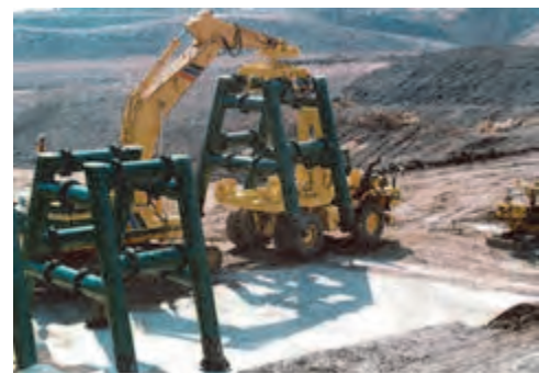
写真-3 鋼製スリット据付け状況
