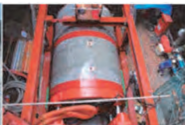
写真-4 掘進状況
