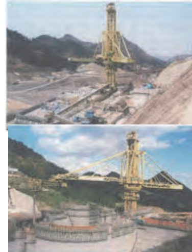
写真-1 施工状況
