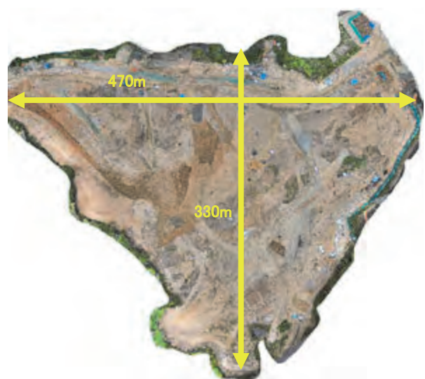
図-2 施工現場全域
