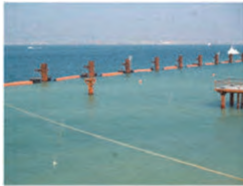
写真-4 汚濁防止膜設置完了
