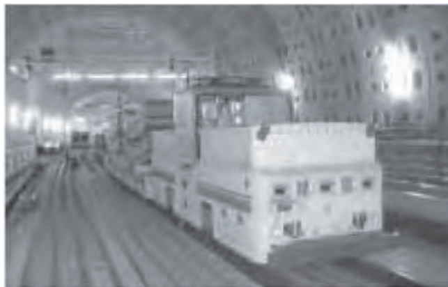
写真-2 自動搬送状況
