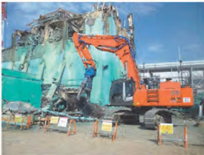
図-2 遠隔操作解体用油圧ショベル
