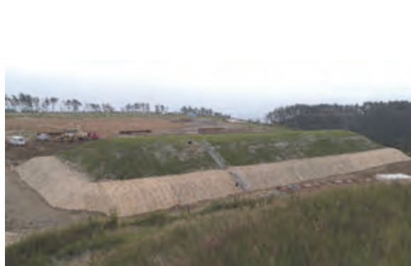
写真-6 覆土式一時保管施設（完了）
