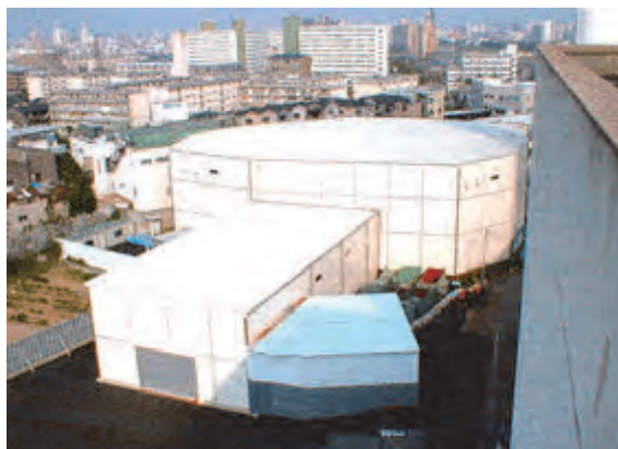
写真-1 工事場所の防塵建屋外観
