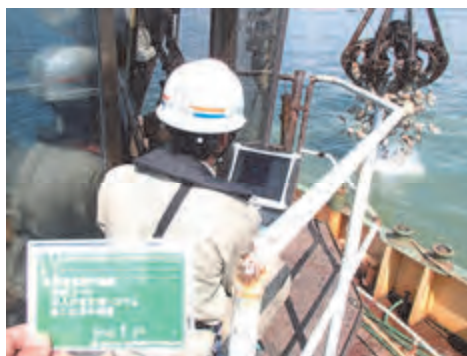
写真-1 捨石投入状況
