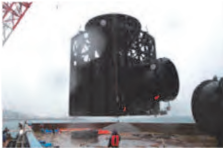
写真-1 取水口 J管設置状況
