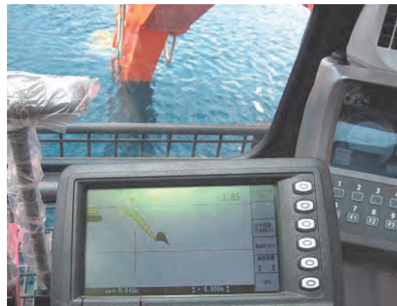
図-6 浚渫工事への適用事例
