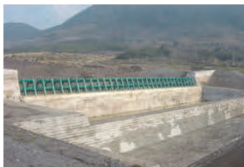
写真-8 竣工状況
