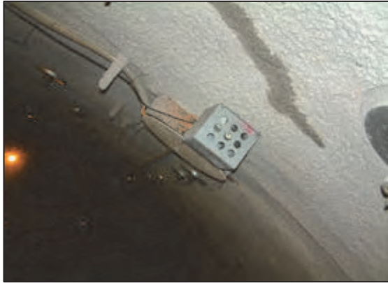
写真-1 発破防護装着状況
