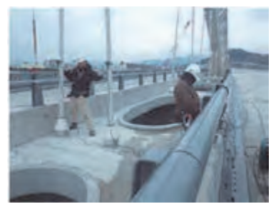
写真-4 振動計測
