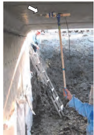
写真-5 施工後のひずみ計測状況
