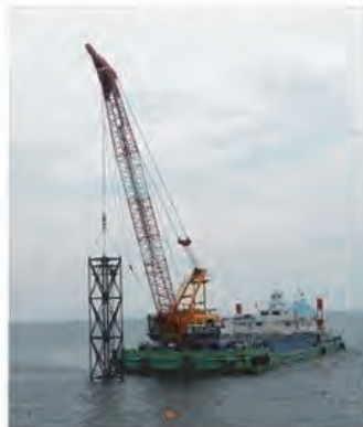
図-2 重錘落下による機械敷均しと設置精度確認状況
