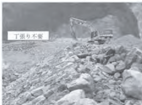
図-5 下流面リップラップ施工状況
