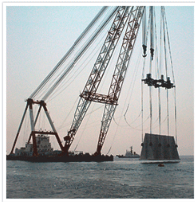
図-2 人工湧昇流設置状況図
