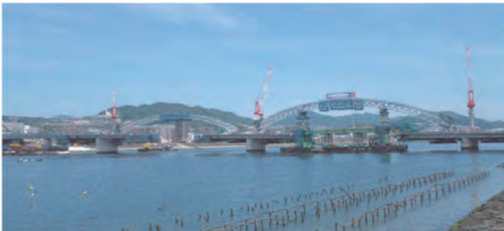
写真-1 アーチ主構の台船一括架設図
