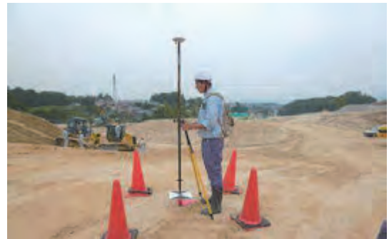
図-3 VRS-GNSSによる基準点測量
