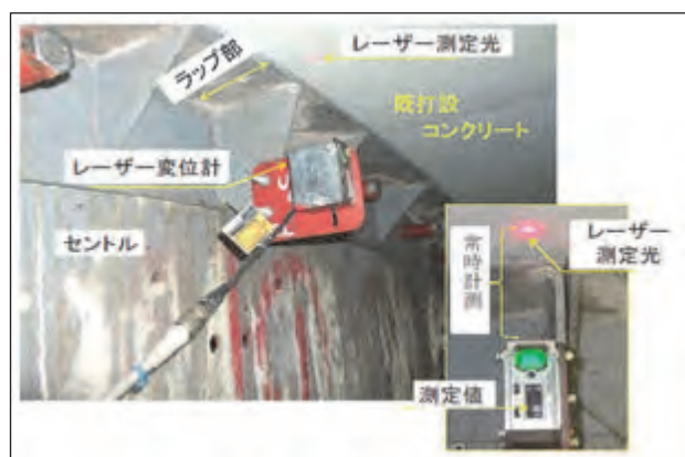
図-5 レーザー変位計による計測状況
