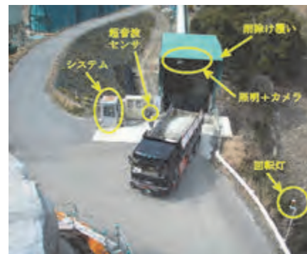
写真-1 現場でのシステムの設置
