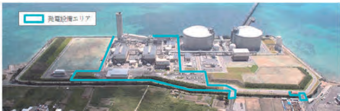
写真-1 発電設備エリア
