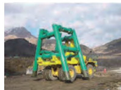
写真-1 スリット運搬状況
