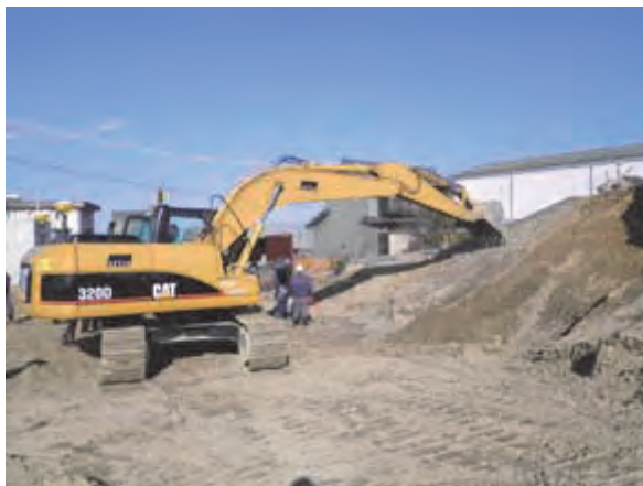
図-5 マシンガイダンスによる法面整形状況
