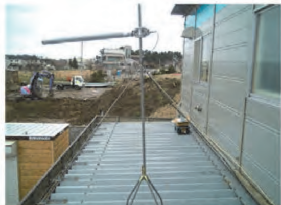
写真-2 受信側アンテナ（指向性）設置例
