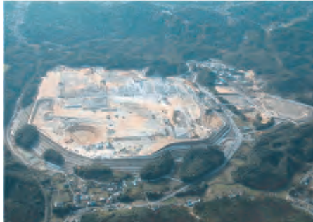
写真-1 工場掘削後全景
