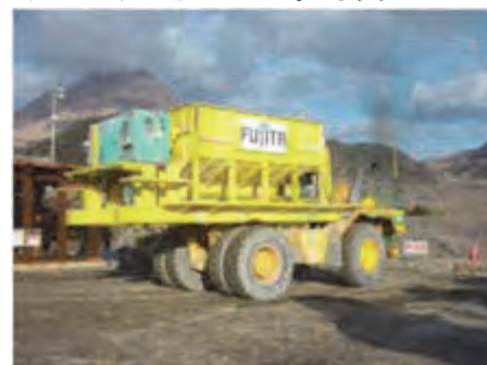
写真-4 高流動コンクリート運搬状況
