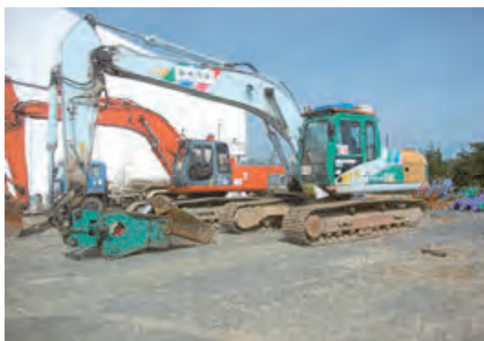
写真-5 無人化施工機械
