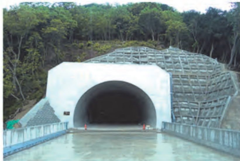
写真-1 十九渕第一トンネル全景
