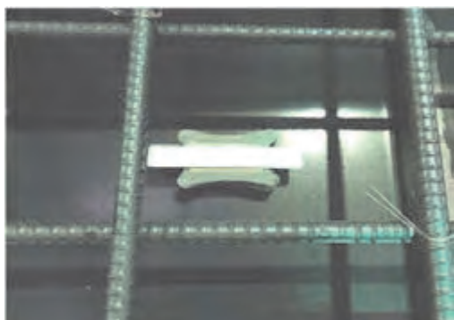
写真-3 スペーサーに固定した埋込み型のRFIDタグ
