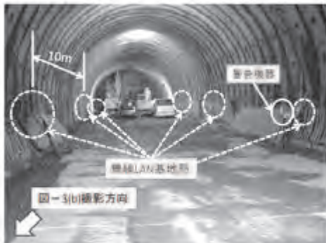
(a) 無線 LAN 基地局および警告機器
