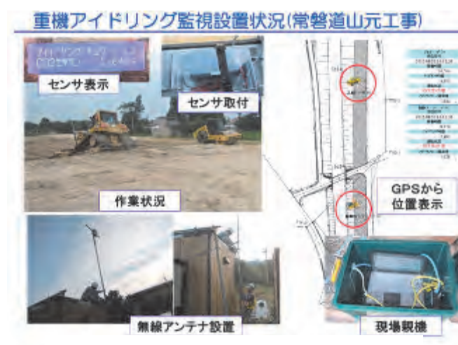
図-2 重機アイドリング監視状況
