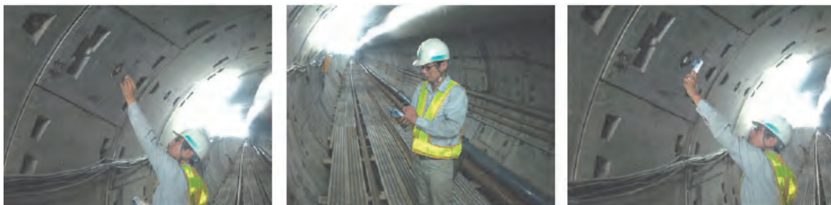
写真-2 IC タグの取り付け（左）、情報入力（中央）、情報登録（右）
