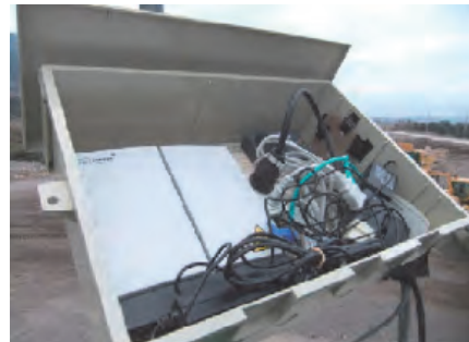
写真-1 衛星通信アンテナ
