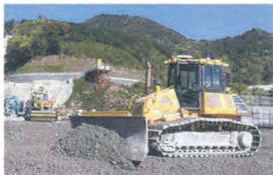
図-2 五ヶ山ダムでの実施状況 (自動ブルドーザと自動振動ローラ)
