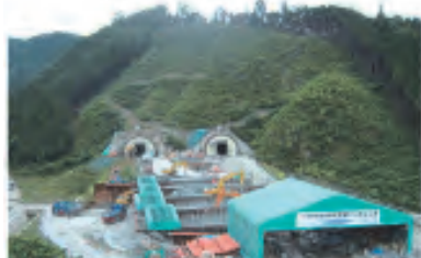
写真-1 鳳来トンネル
