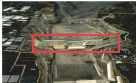
図-2 砂防ダム完成状況
