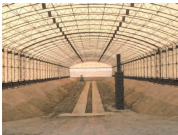
写真-3 覆土式一時保管施設
