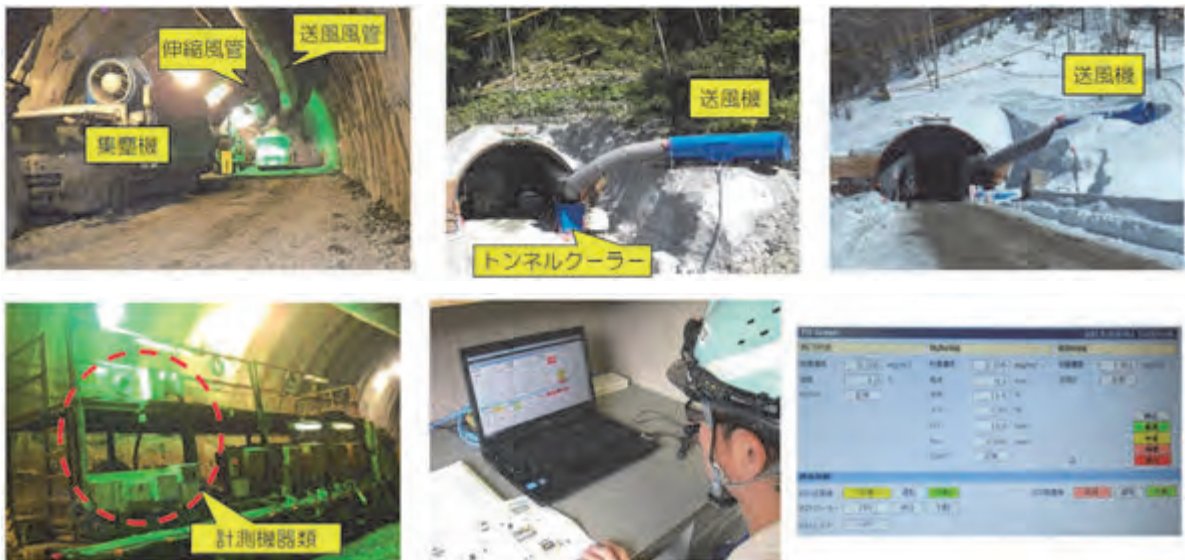
写真-1 システム稼働状況
