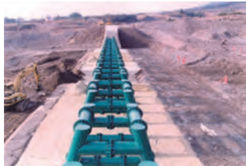
写真-7 鋼製スリット配置完了状況
