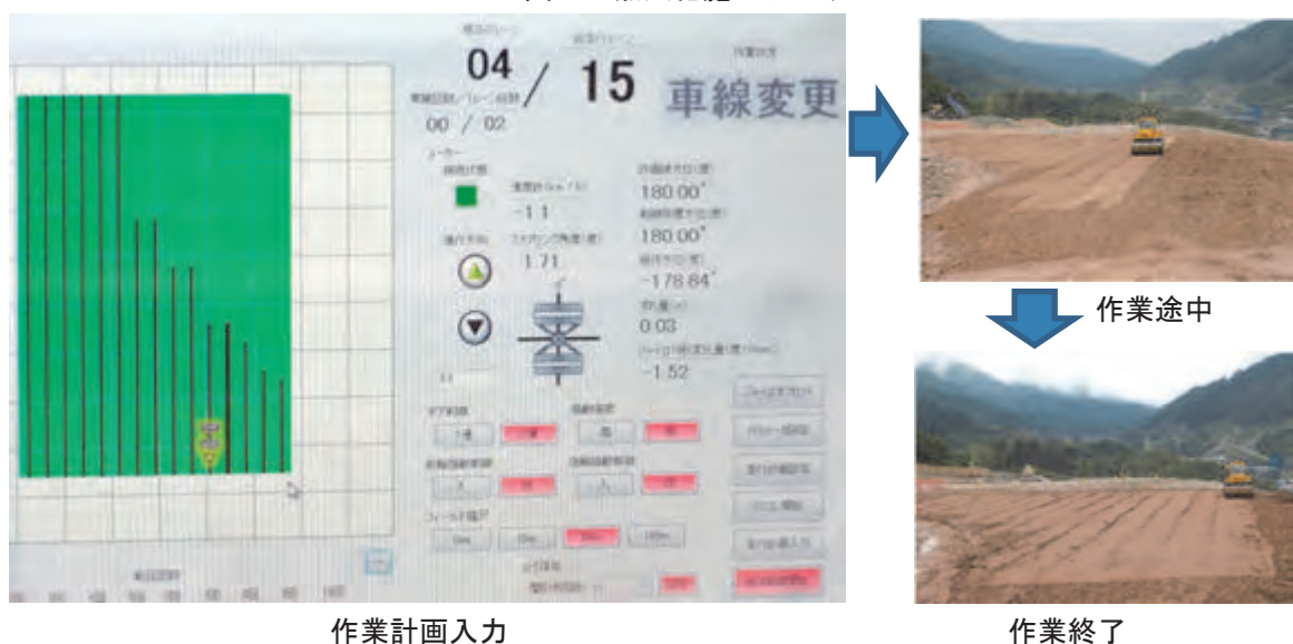
写真-1 無人化施工の流れ
