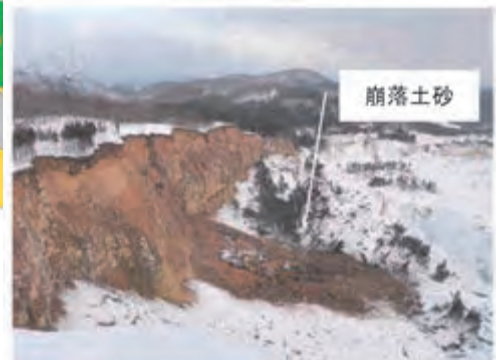
写真-2 東側斜面の崩落
