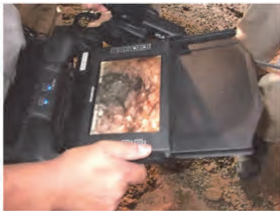
写真-1 DRi スコープによる調査状況
