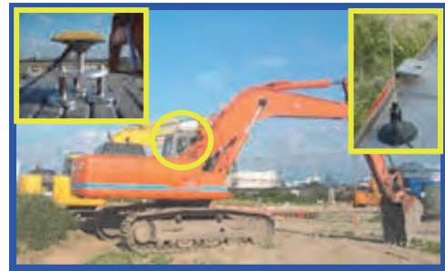
写真-3 掘削機械に搭載した GPS 基準局
