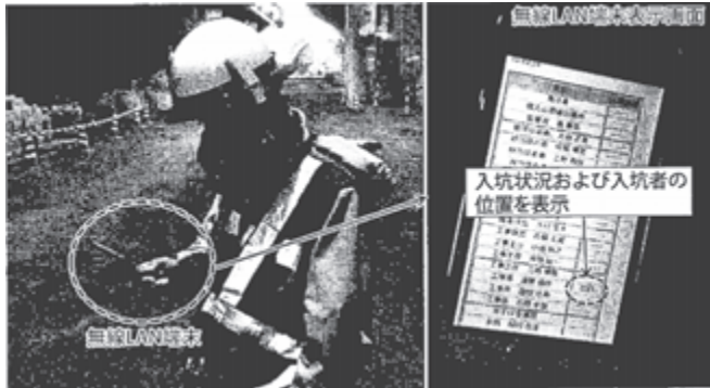
図-2 無線 LAN 端末使用状況と位置表示状況
