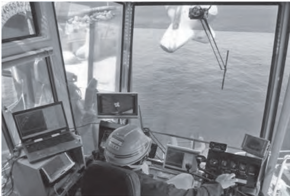
写真-1 クレーン操作状況
