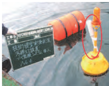
写真-4 浮標灯設置
