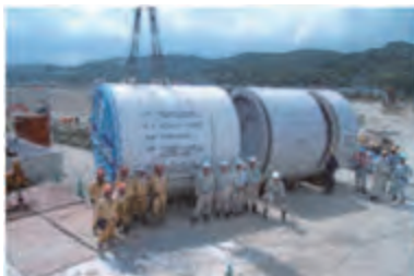
写真-3 推進機全景
