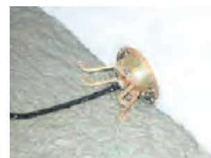
写真-2 充填材検知センサの設置状況
