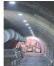
写真-3 坑内のLED照明
