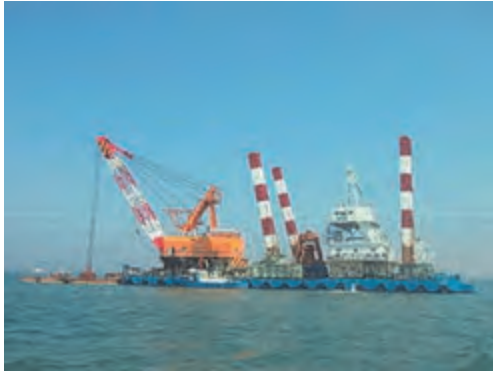
写真-1 浚渫状況
