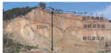
写真-1 滑落崖全景
