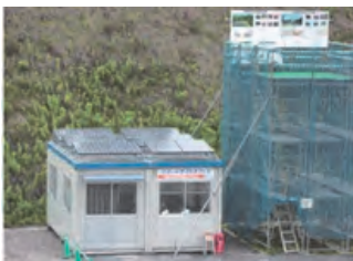
写真-5 スマートサイト オフィス（外観）
