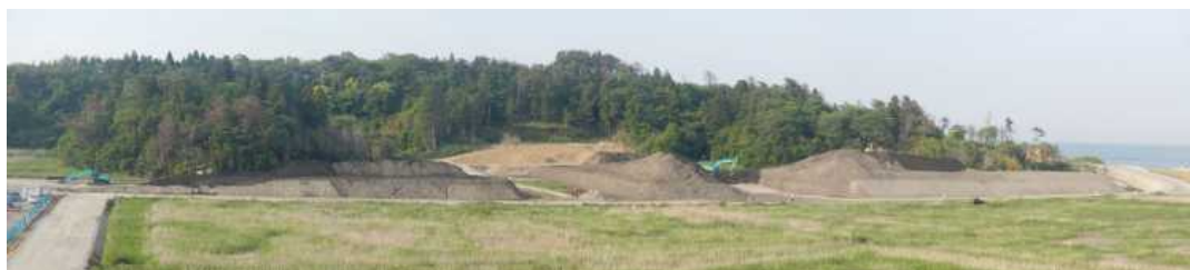
新地町磯山地区へ再生資材運搬
