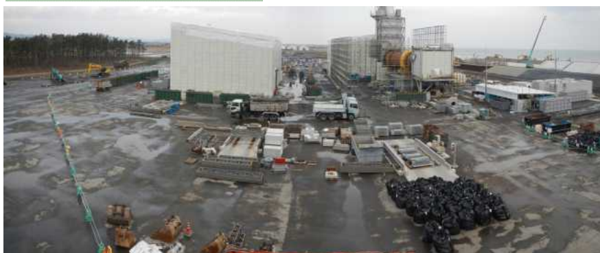
焼却炉解体状況 ストーカ炉(左側)は建屋内で解体中、キルン炉は内部除染中
