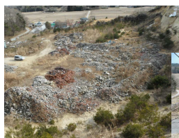
真庭一次仮置場 着手前
