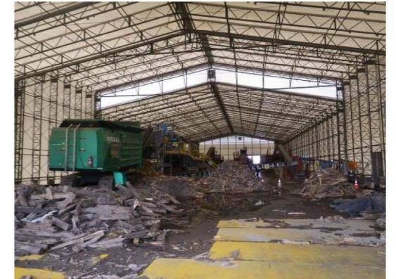
図 7. 破碎選別プラントへのテント設置
