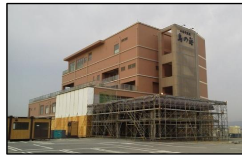
写真 4-1 「わたり温泉 鳥の海」改修状況
