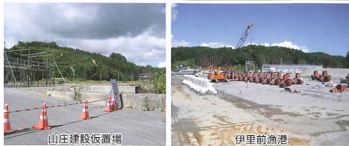
歌津の山庄建設仮置場からきれいにガレキは無くりました。 伊里前漁港のガレキは一掃され、現在は復興への第一歩を踏み出しています。
