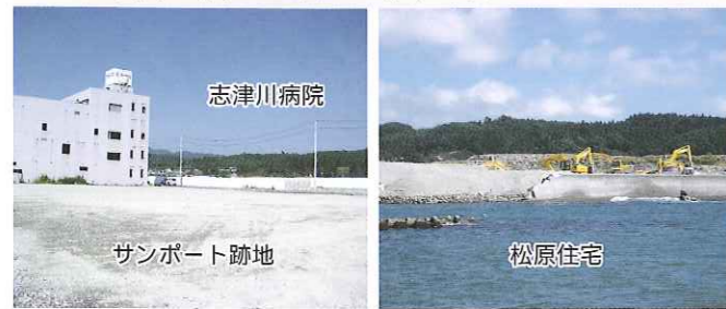
志津川病院現況写真 解体工事は完了し、コンクリートガラは再生砕石へと生まれ変わりました サンポート跡地 松原住宅現況写真 2棟あった松原住宅は解体され、再生砕石の生産中です
