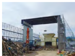
破砕機と防音テント
