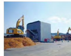
木くず破砕機と防音テント
