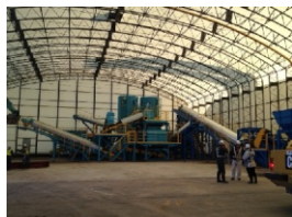
造粒固化施設
