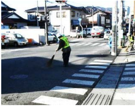
② 道路の清掃作業
