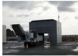
木くず破砕機と防音テント
