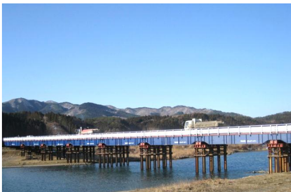
津谷川に掛かる仮橋を通るダンプ
