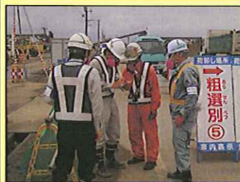
【2日目：保護具総点検の日】 現場にて保護具の点検を実施
