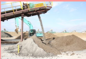
改良後の汚泥
