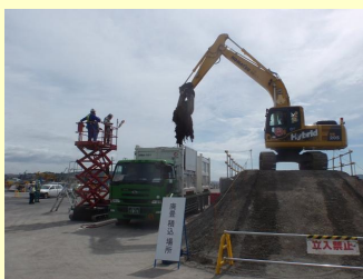
専用の作業台から量を積み込みます
