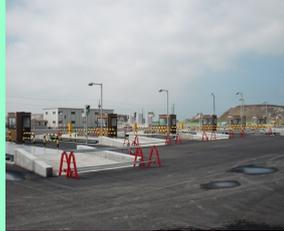
①一次仮置き場から運搬されたがれきは、このトラックスケールでトラックごと計量された後、粗選別エリアに運ばれます。
