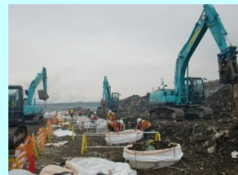
混合廃棄物のフレコンバッグ詰め状況。県外搬出の目途が立たないため、ヤード内や周辺の空地への仮置きを行っています。
