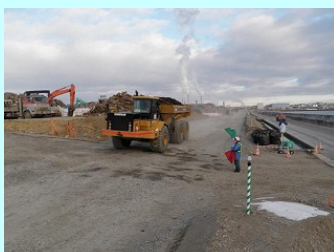
ヤード内に山積みされた津波堆積物（津波によって陸にあげられた土砂）の運搬には、35t重ダンプが活躍しています。
