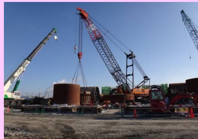
焼却炉の組立状況
