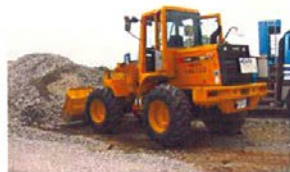
1.3m3タイヤショベルによる再生砕石積込み
