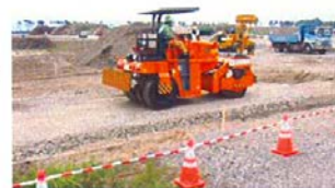
再生砕石による基礎盛土の施工
