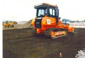
10tブルドーザによる土砂撤出し(30cm/層)、敷均し
