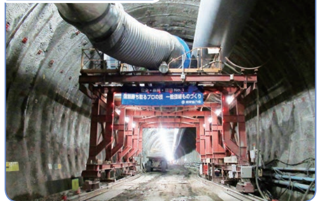
設備台車と集じん機
