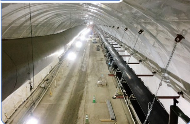
ベルトコンベアによるズリ搬出
