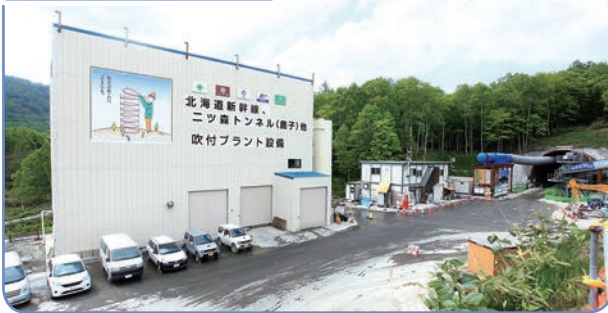
大容量SECプラント
