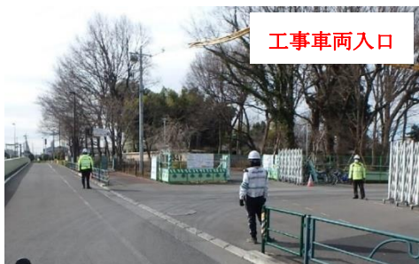
交通誘導員配置状況(通常時)
