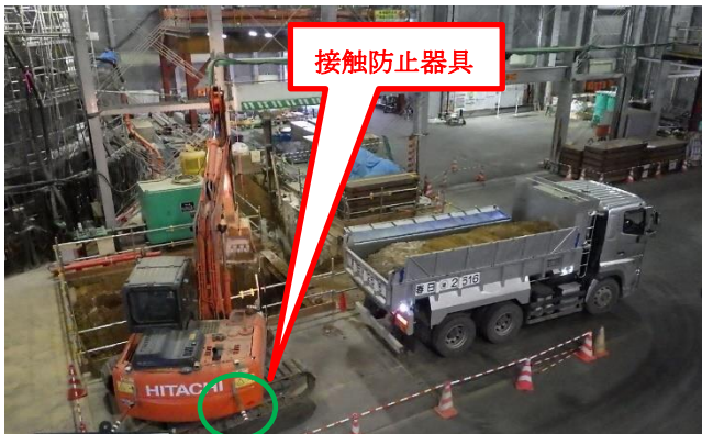
重機周り区画明示
