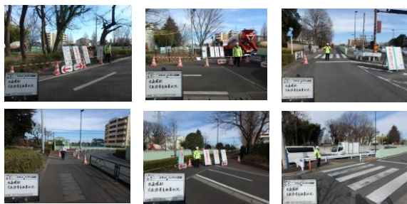
交通誘導員配置状況(コンクリート打設時)
