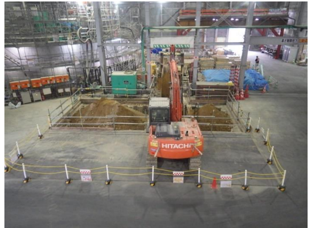
防音ハウス内施工状況
