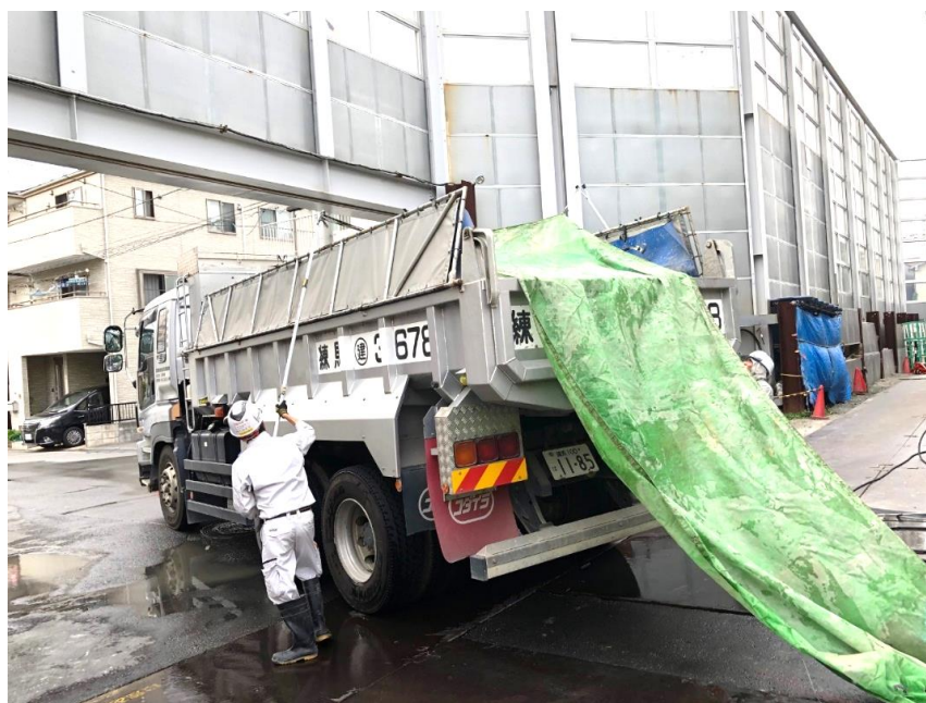
写真-3 荷台シート掛け状況
