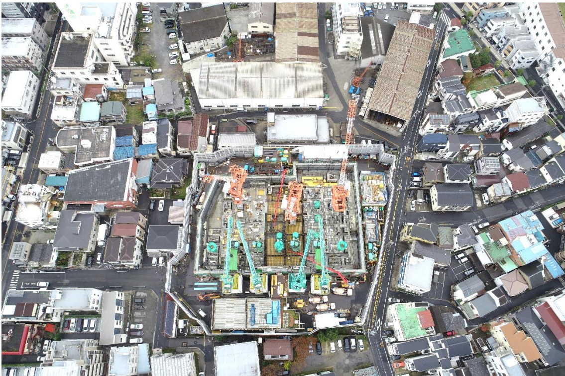
写真-1 掘削工施工状況
