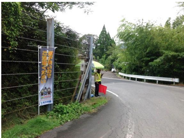
交通誘導員と安全看板
