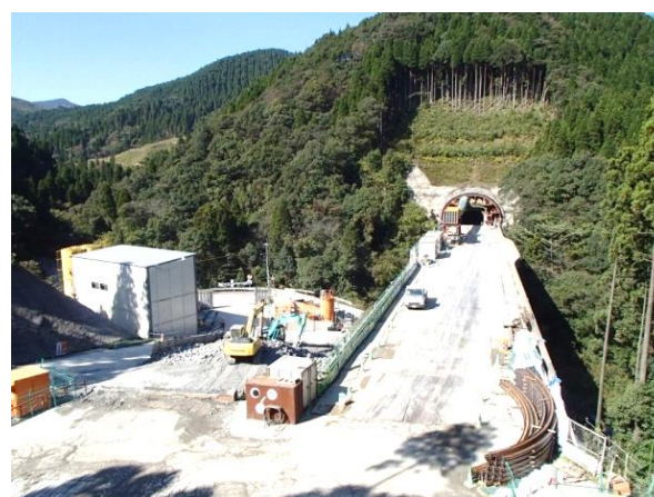
トンネル坑口周り状況
