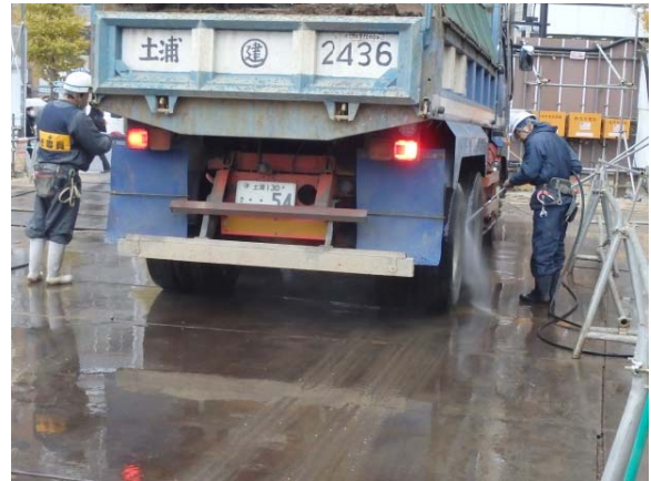
タイヤ洗浄状況
