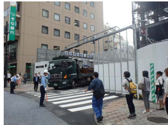
車両誘導状況
