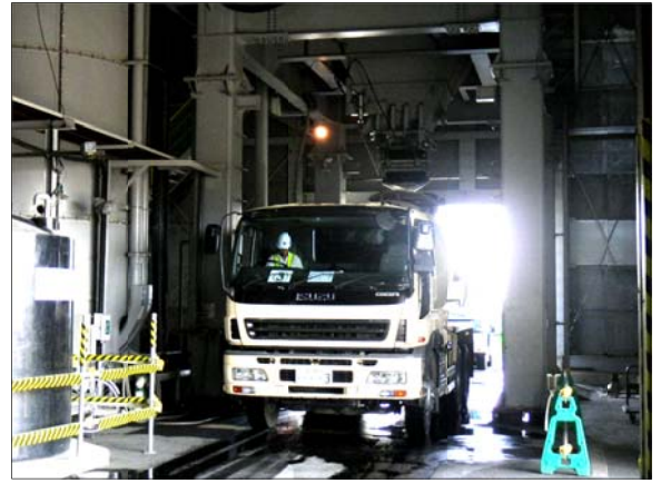
バッチャープラント内状況（1F）
