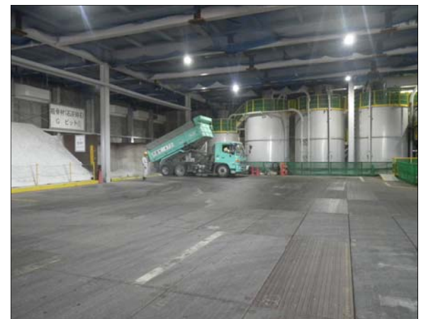
バッチャープラント内状況（2F）
