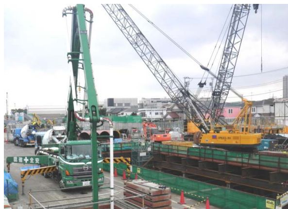
工事現場状況 1 (地上)
