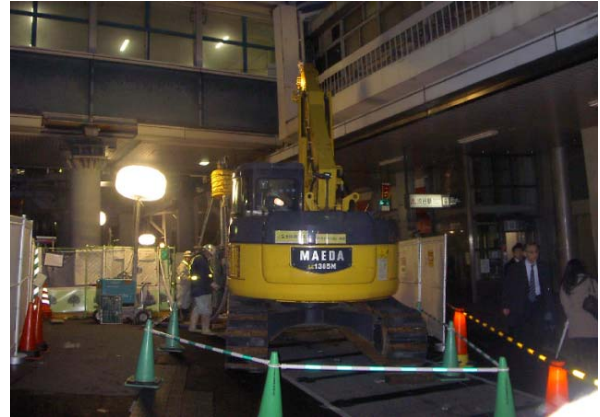
写真－8 フェンスによる通路の明確化
