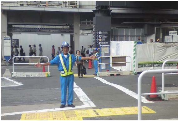
写真-1 仮設横断歩道誘導状況
