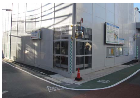
クリアパネル設置状況
