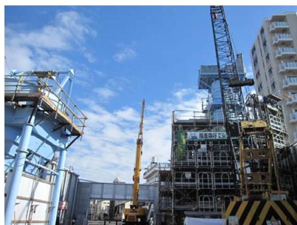
工事現場状況
