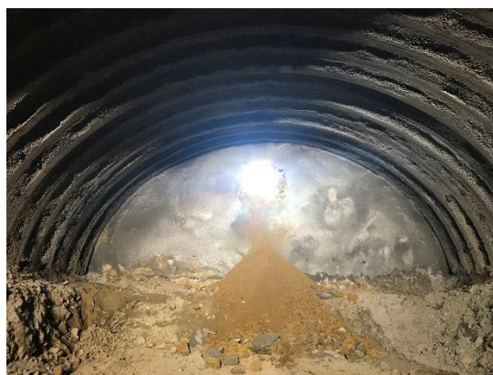
写真-17 貫通写真
