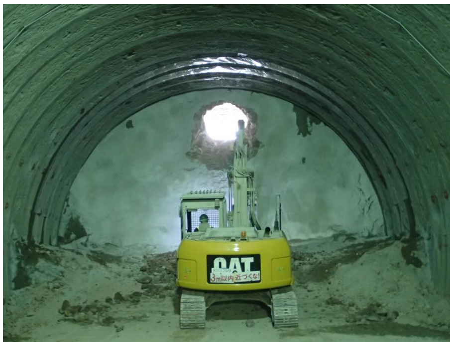
トンネル貫通
