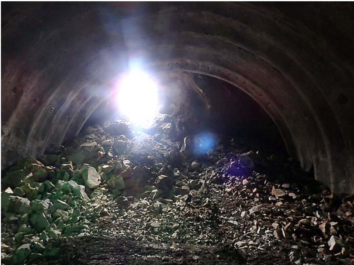
トンネル貫通
