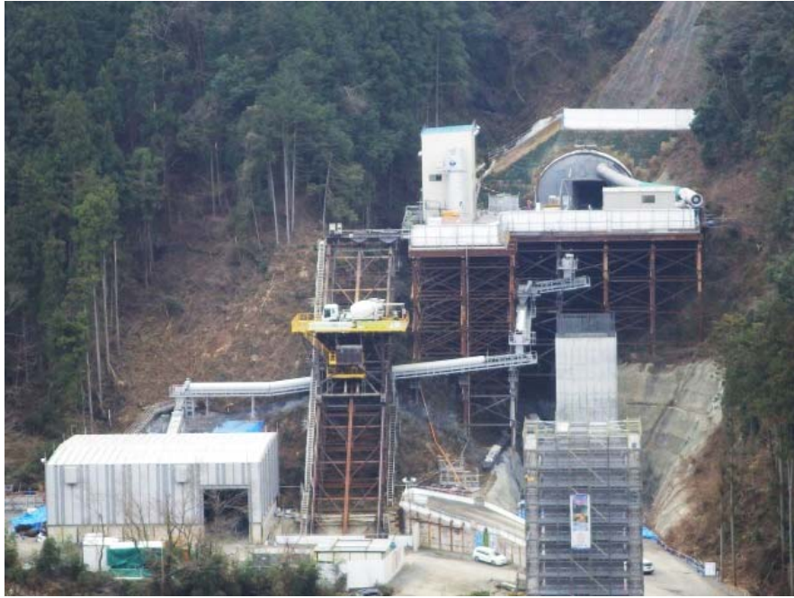
坑口と仮設備全景(インクライン設備含む)
