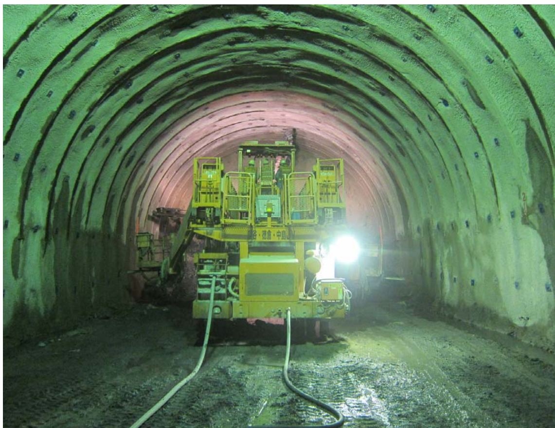
発破削孔状況
