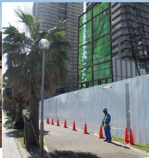
・歩道側からの写真：ガードマンによる注意喚起と飛散状況の確認を実施
