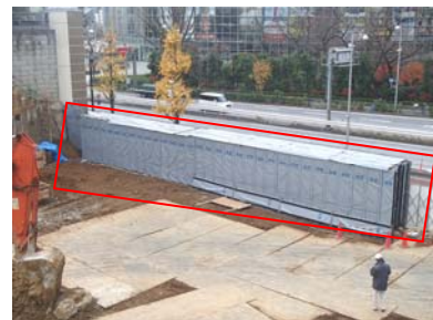
写真-3 防音パネル設置 (障害物)
