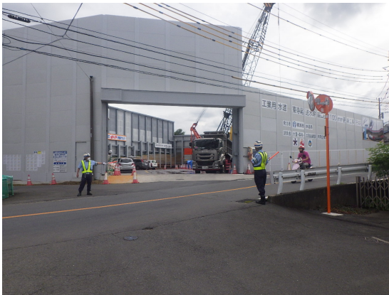
【出入口(ガードマン・カーブミラー)】
