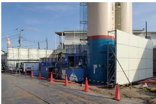
プラント周りの防音壁設置状況
