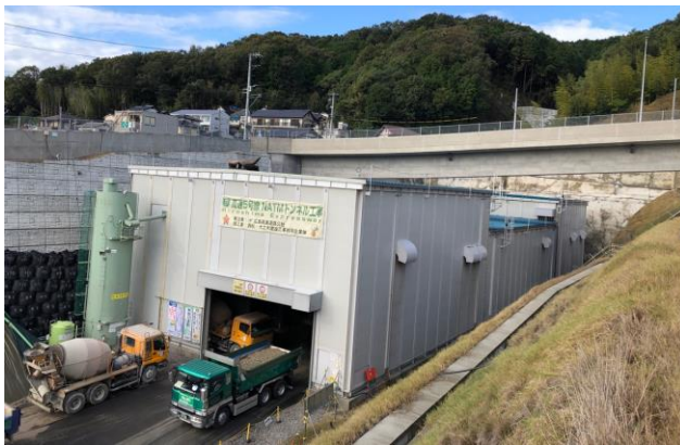
防音ハウス全景
