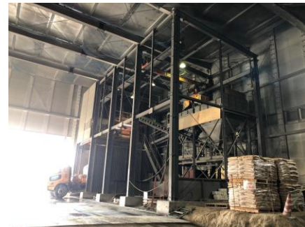
コンクリートプラント（ハウス内）
