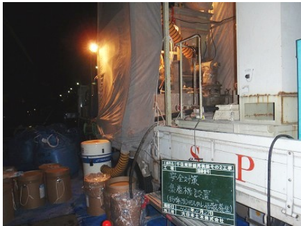
粉塵飛散養生（集塵機設置）
