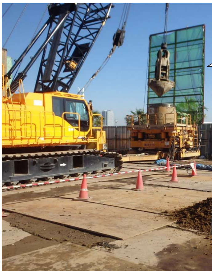
・現場内からの写真：飛散防止ネットが作業に支障となっていない
