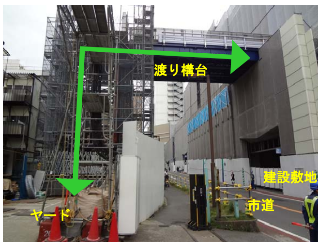
渡り構台はヤードと建物を約13mの高さで接続
