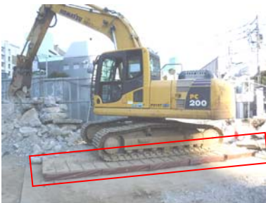
写真-1 防振マット設置
