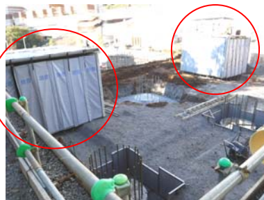
写真-2 防音パネル設置 (杭頭)
