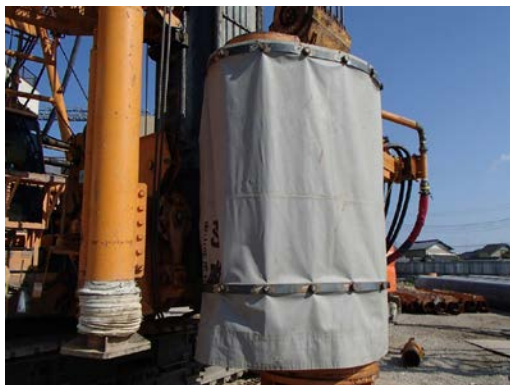
防音シート設置状況 (1)
