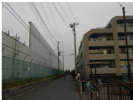
← b.マンションへの騒音対策として設置した防音パネル (H:7m)
