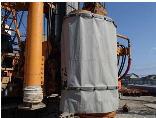
防音シート設置状況 (1)
