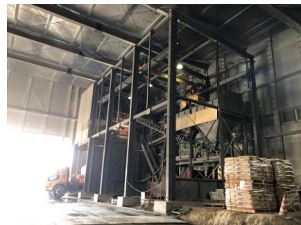
コンクリートプラント（ハウス内）
