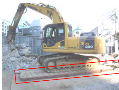
写真-1 防振マット設置
