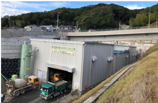
防音ハウス全景
