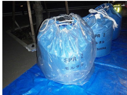
粉塵飛散養生（モルタルフレコンパックへのビニールカバー取付）
