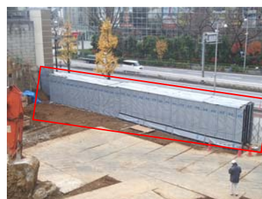
写真-3 防音パネル設置 (障害物)
