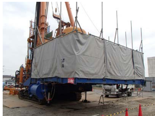
防音シート設置状況 (2)
