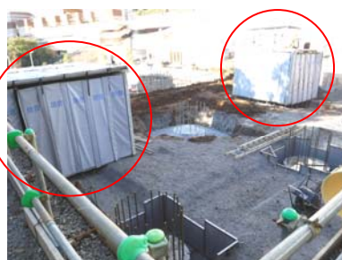
写真-2 防音パネル設置 (杭頭)
