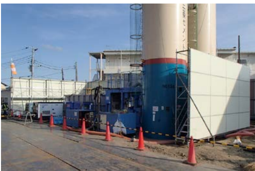
プラント周りの防音壁設置状況
