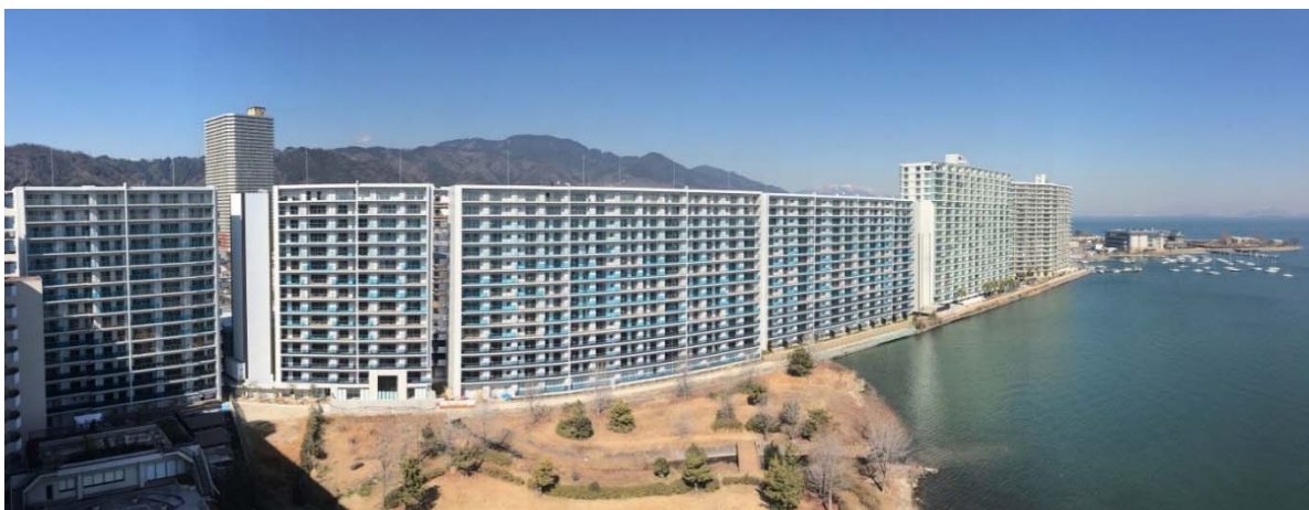
マンションの外観が完成し、外構を施工中
